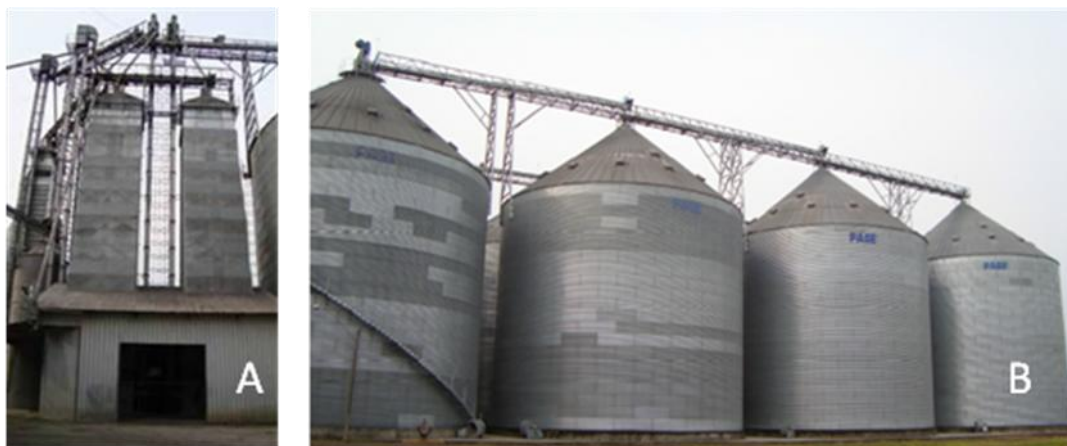
Figura 4. (A) Silos secadores (B) Silos de armazenamento (Cooperja, acesso em 23/12/2016, www.cooperja.com.br/produtos/producaodearroz.pdf ).
